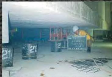
国立西洋美術館本館の床下では、地面との間で計49台の高減衰積層ゴムによる免震装置が建物を下から支えています。免震装置1台あたり、約140~300tの建物の重さがかかります。
