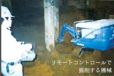
リモートコントロールで掘削する機械
