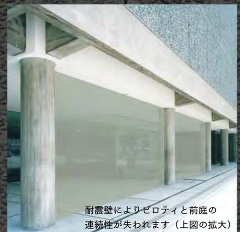
耐震壁によりピロティと前庭の連続性が失われます（上図の拡大）
