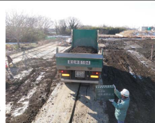
盛土材の搬入状況
