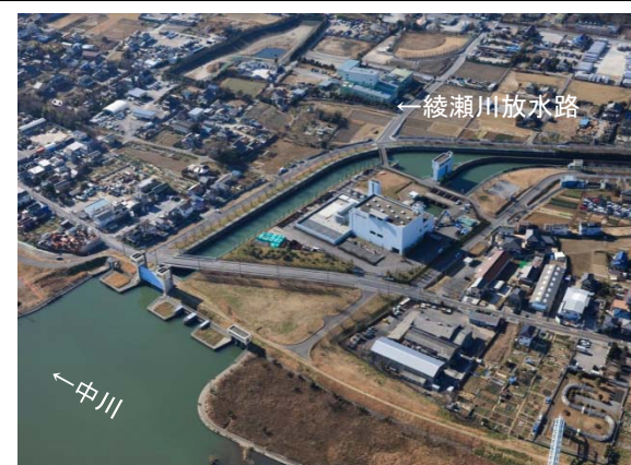
八潮排水機場 (綾瀬川放水路)
