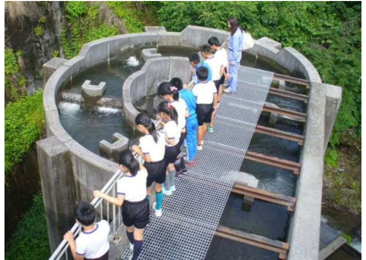
上木馬瀬砂防堰堤 魚道見学
