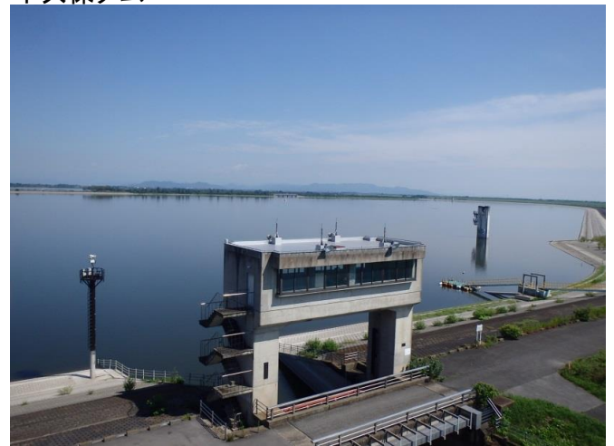
渡良瀬貯水池
