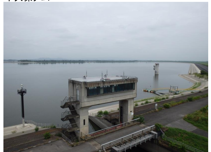
渡良瀬貯水池
