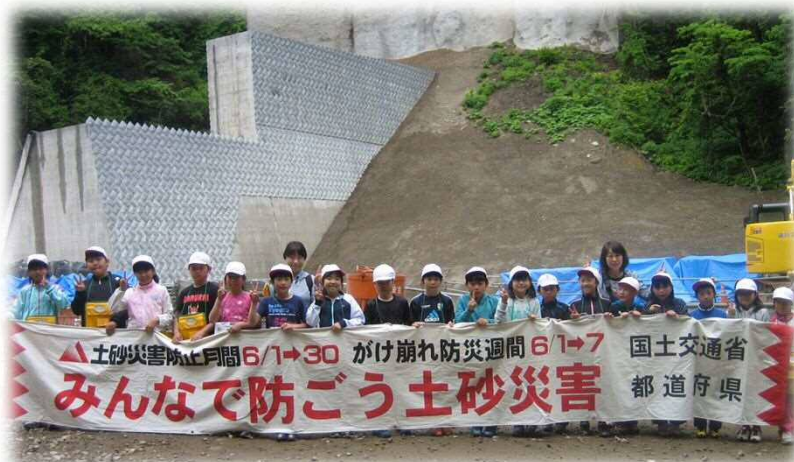
【谷沢川第五砂防堰堤工事】
