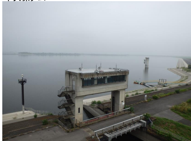
渡良瀬貯水池
