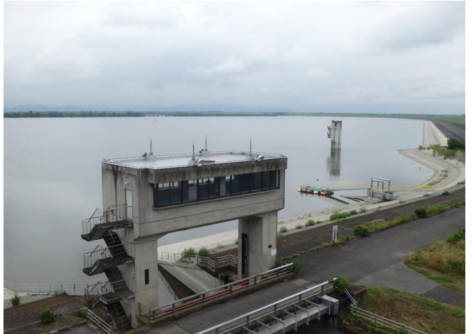
渡良瀬貯水池
