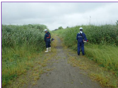
除草作業前:松戸出張所職員(2名) 直営部隊ワンド池出入口付近にて
