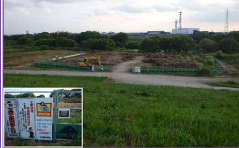
翌日6月8日(水)仮囲い設置
