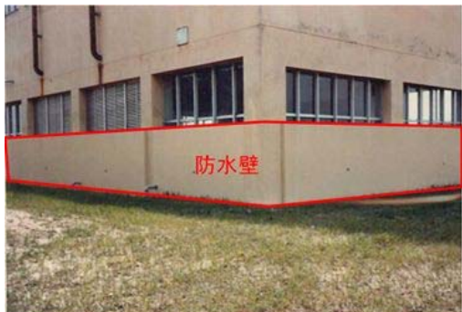
機場建屋の浸水対策を実施
