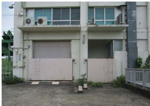
入口にゲートを設置
