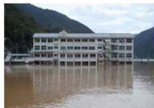
H26.8避難所2階の浸水 (徳島県)
