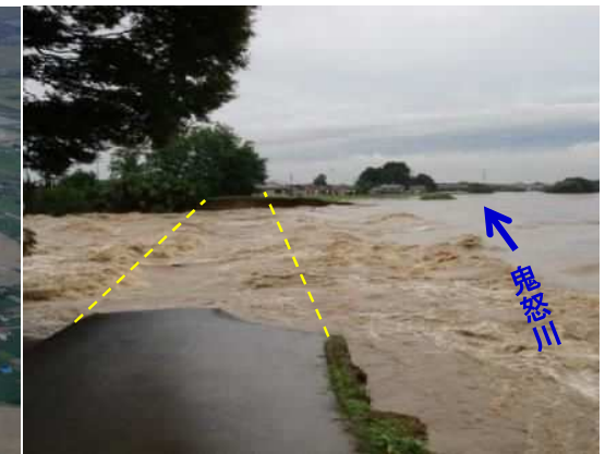
被災状況(拡大写真)
