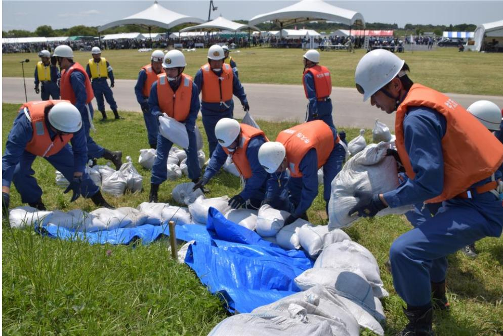
堤防からの漏水を 抑える月の輪工法
