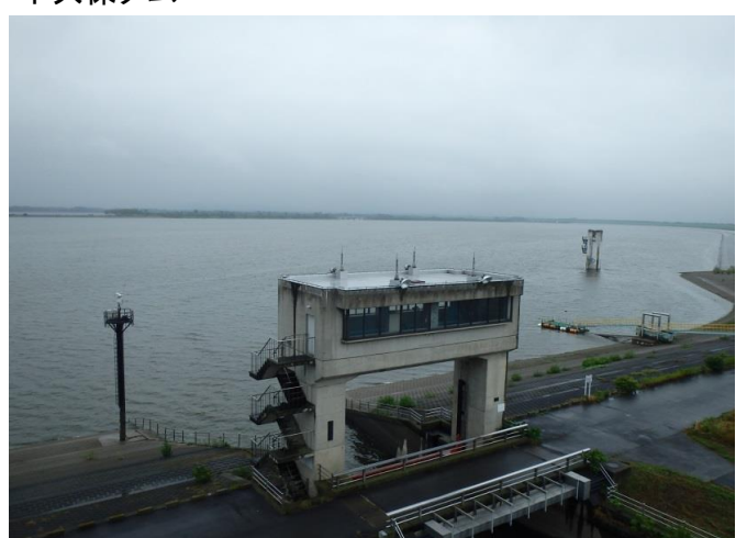
渡良瀬貯水池
