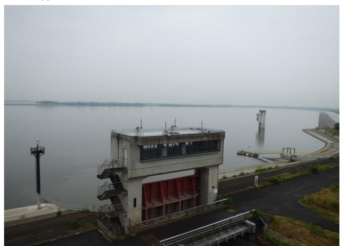
渡良瀬貯水池
