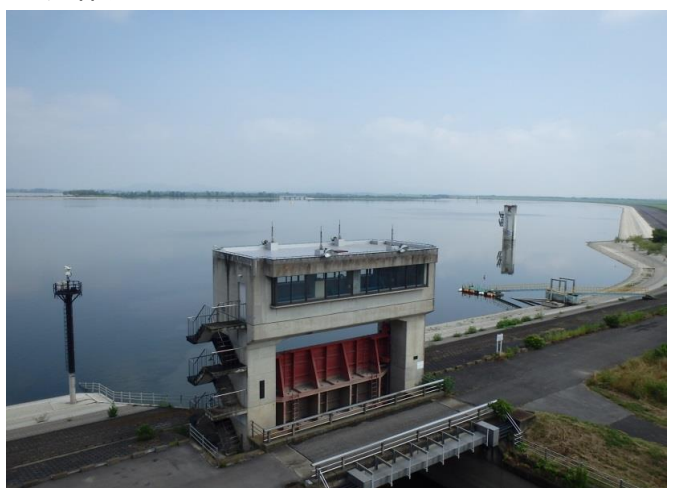
渡良瀬貯水池
