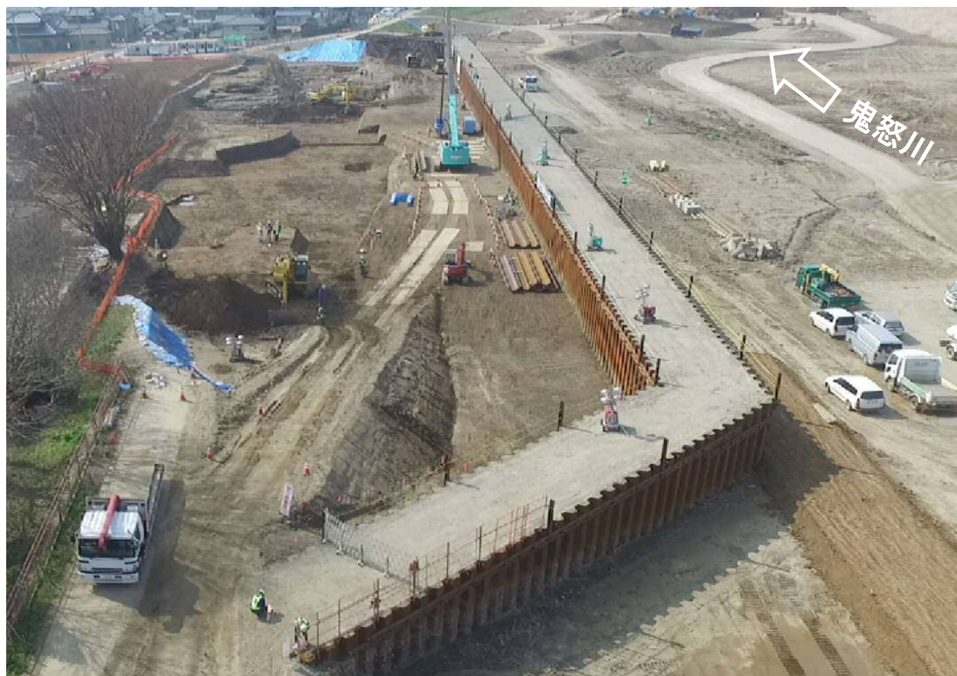
置換盛土基盤の掘削整形状況(3月4日撮影)
