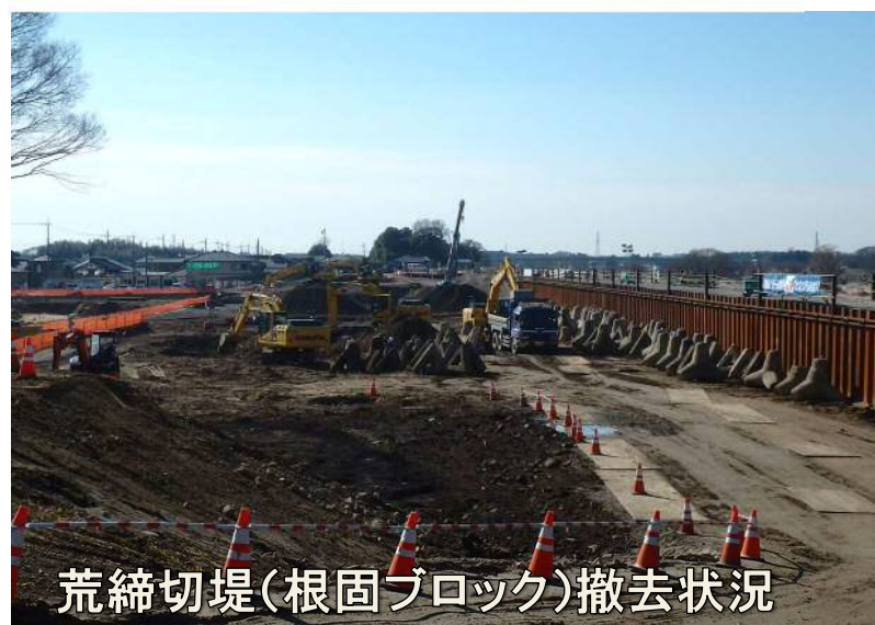
荒締切堤(連節ブロック)撤去状況
