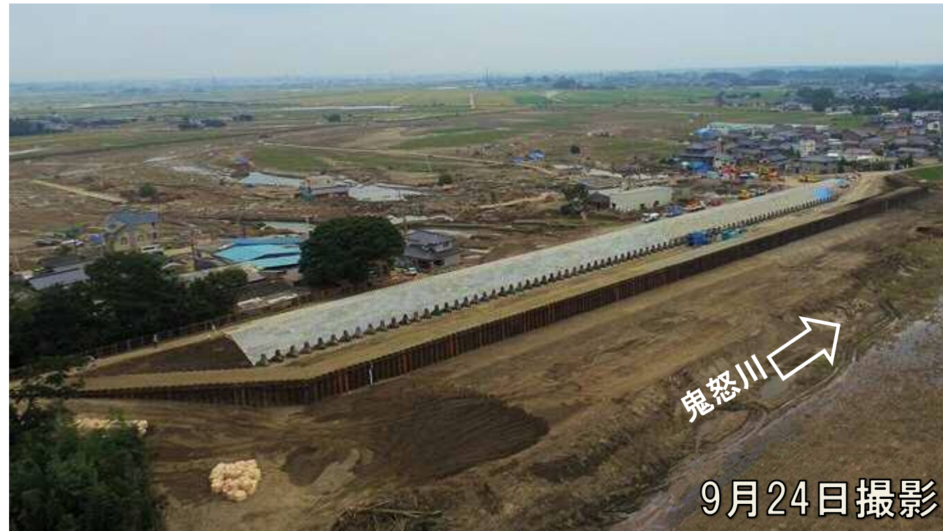
緊急復旧工事(荒締切堤・二重締切堤)完成時の状況
