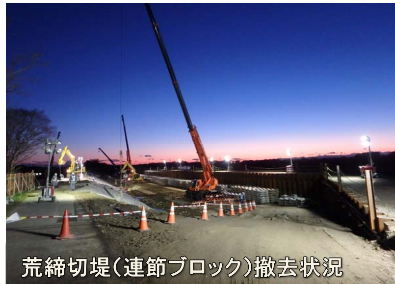
荒締切堤(中詰土砂)撤去状況
