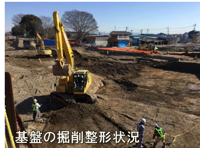
堤防基盤(深掘部)の掘削・整形・置換盛土
