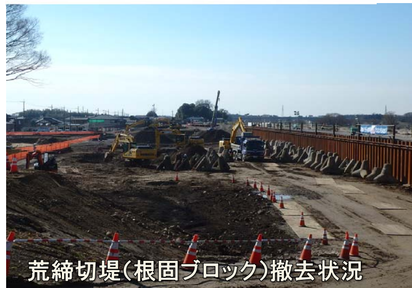
荒締切堤(連節ブロック)撤去状況
