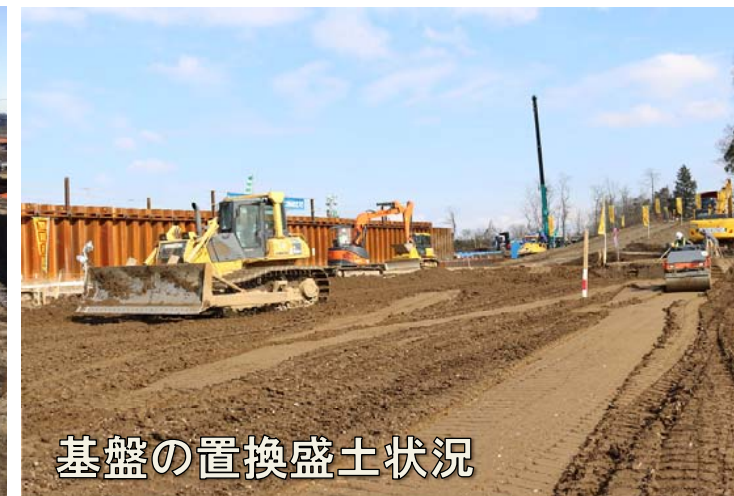
堤防基盤(深掘部)の掘削・整形・置換盛土
