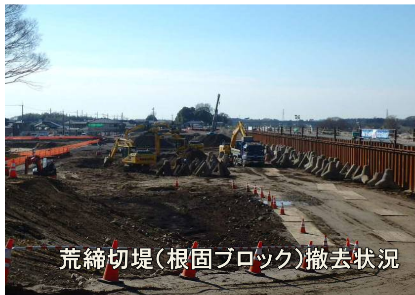
荒締切堤(連節ブロック)撤去状況
