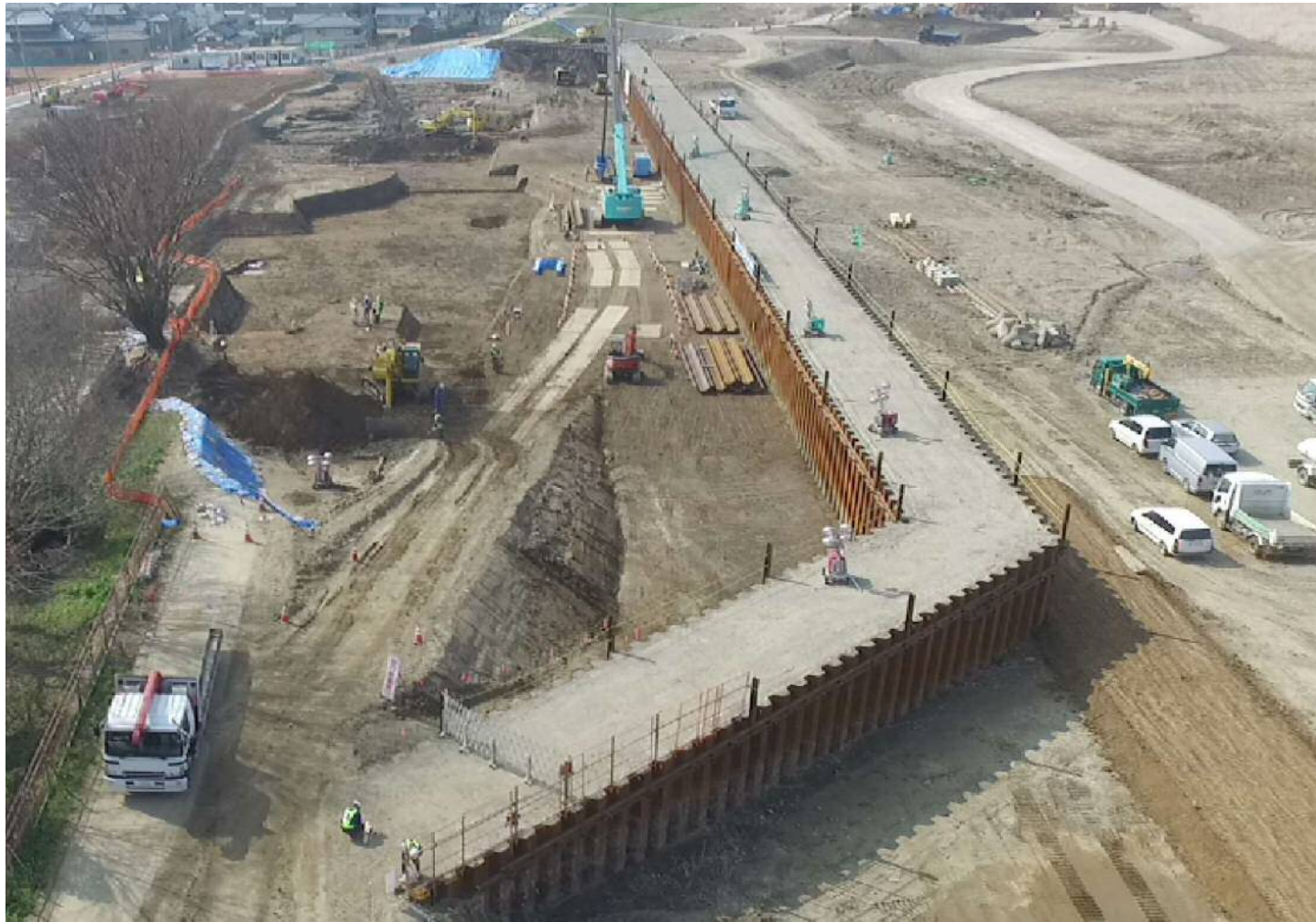
置換盛土基盤の掘削整形状況(3月4日)
