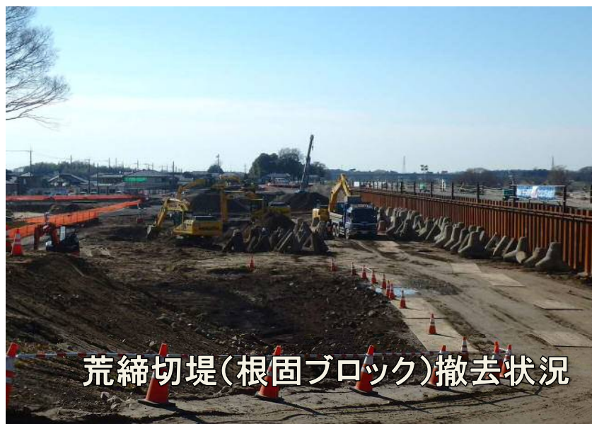
荒締切堤(連節ブロック)撤去状況
