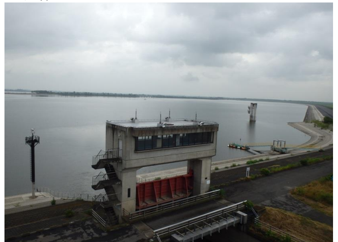
渡良瀬貯水池
