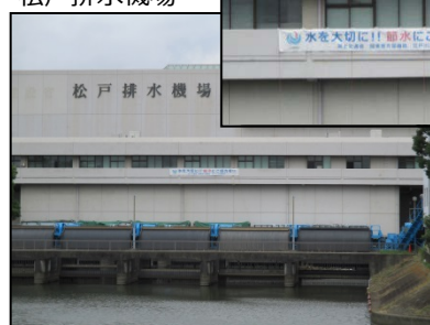
松戸排水機場
