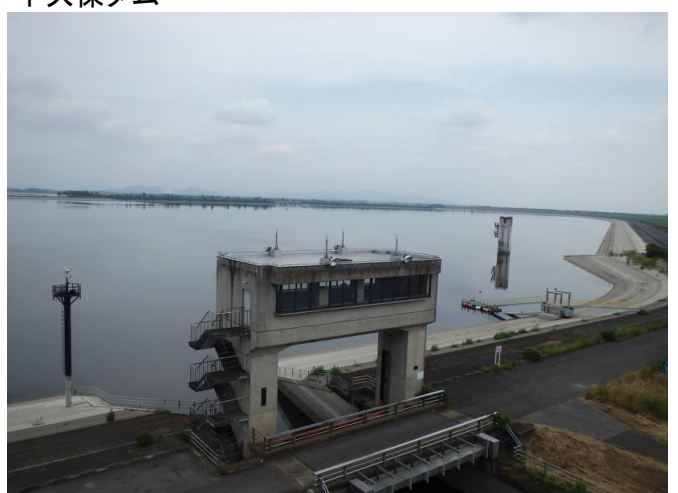
渡良瀬貯水池
