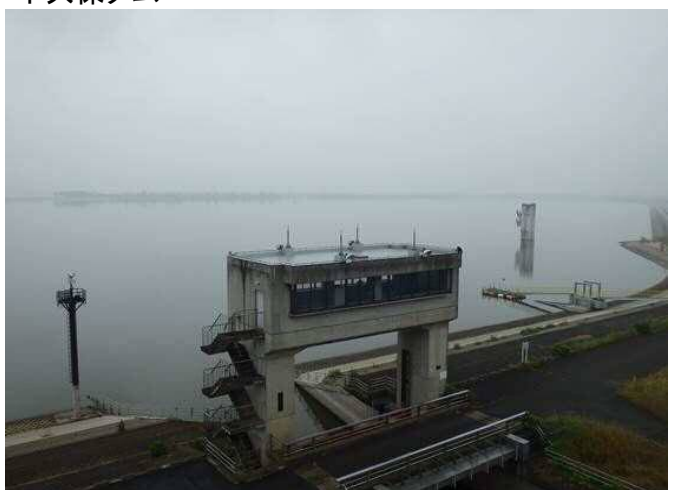
渡良瀬貯水池
