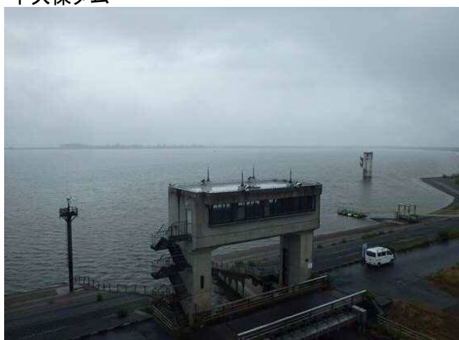
渡良瀬貯水池
