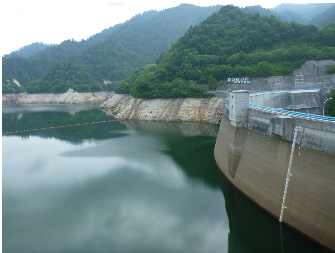
矢木沢ダム上流部（平成28年6月7日撮影）
