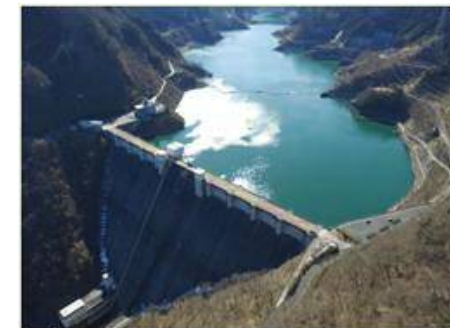
浦山ダム（平成11年完成）
