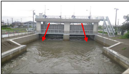
佐間水門洪水取込状況
