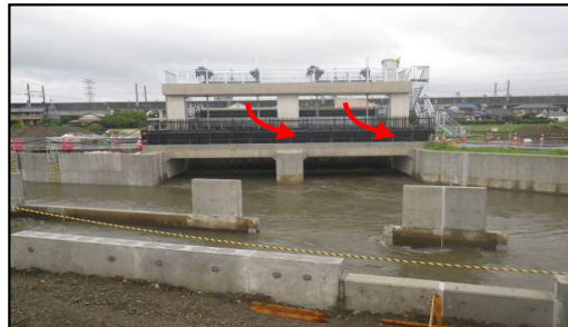
川面水門地点の洪水取込状況
