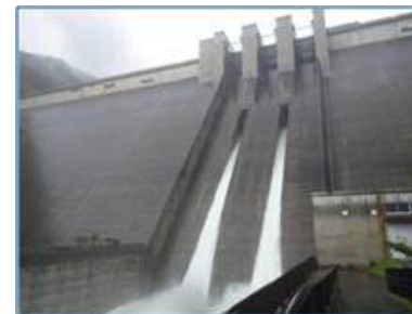
低減された水量を ダムから放流
