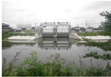
星川水門(新設)
