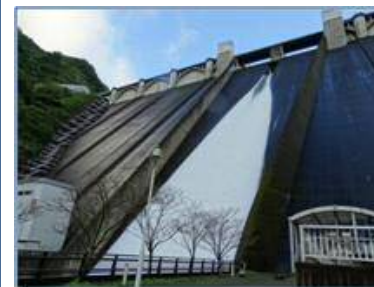
低減された水量を ダムから放流
