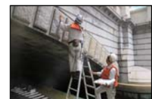
近接目視による橋梁点検
