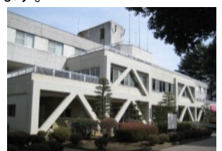
総合運動公園事務所(栃木県)
