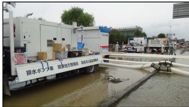
排水ポンプ車による排水作業 (関東・東北豪雨)
