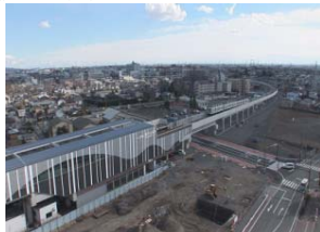
JR両毛線・東武鉄道伊勢崎線 連続立体交差事業(群馬県)
