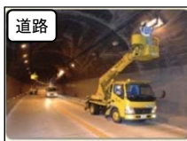
道路 トネルの点検
