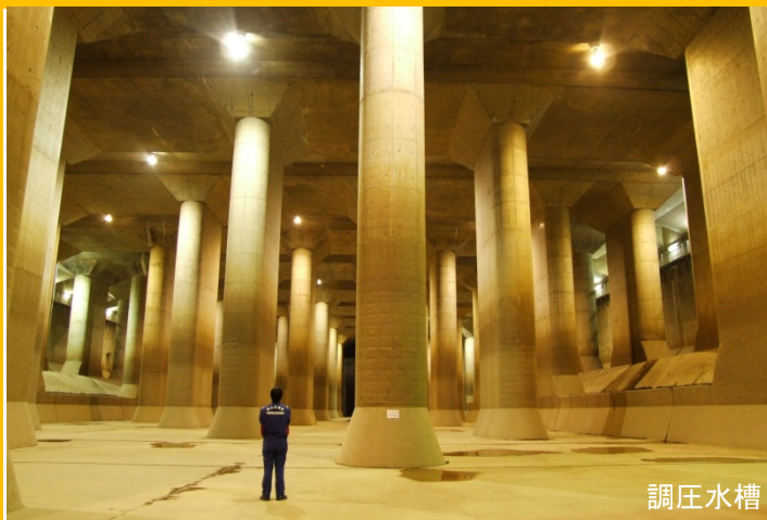
○中川・綾瀬川流域の治水施設 首都圏外郭放水路
