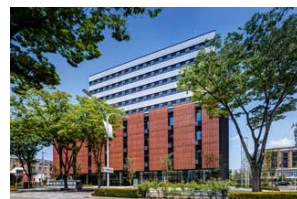
【前橋地方合同庁舎】
