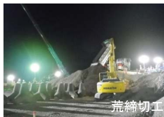
大型土のう積終了(越水箇所)
