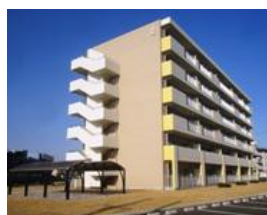
公営住宅整備事業(茨城県)
