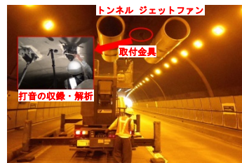
トンネル・ジェットファン 取付金具 打音の収録・解析
