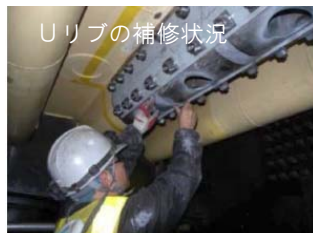
デッキ貫通型き裂の検知手法
