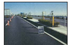
工夫・コスト削減事例 中央分離帯の緑地面積を削減
