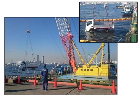
障害物の発生した水域の航路啓開
