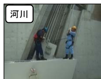
河川 水門の点検
