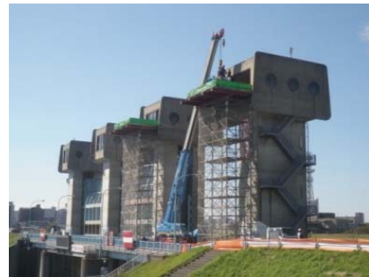
治水上重要な水門等において、耐震対策工を実施します。
