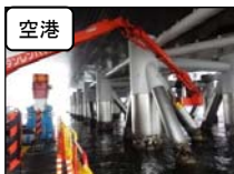
空港 滑走路機橋部の点検
