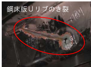
デッキ貫通型き裂の検知手法
