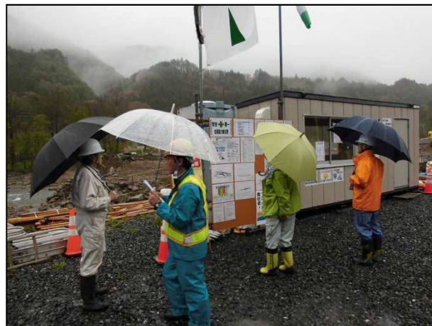
工事現場内をパトロール。事故が起きないように、よくチェック
