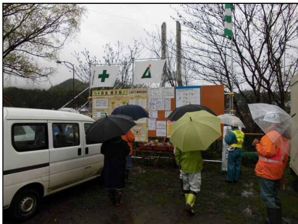
工事現場事務所周辺でのパトロール
