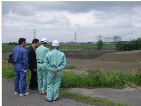
施工場所であった流山ストックヤード (千葉県流山市深井新田地先)にて。
