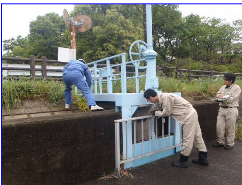
坂川(放水路)の履行検査の状況
