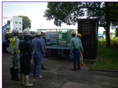
操作制御設備修繕工事における操作盤試運転状況の工事安全パトロール
