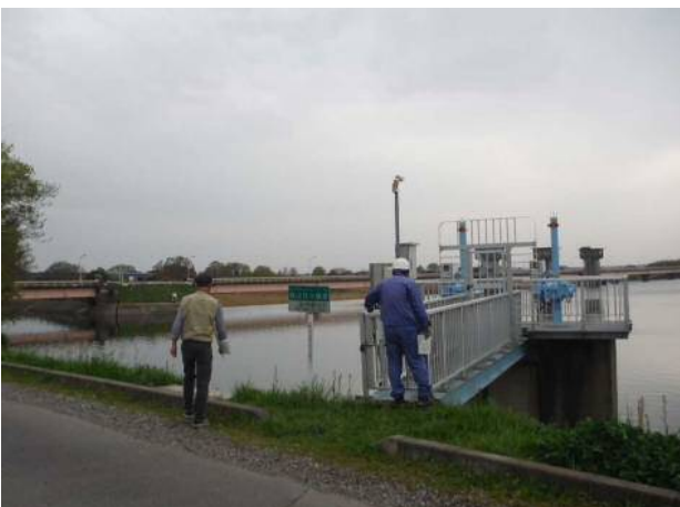
樋管の点検状況
