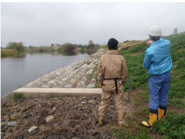
低水護岸の点検状況
