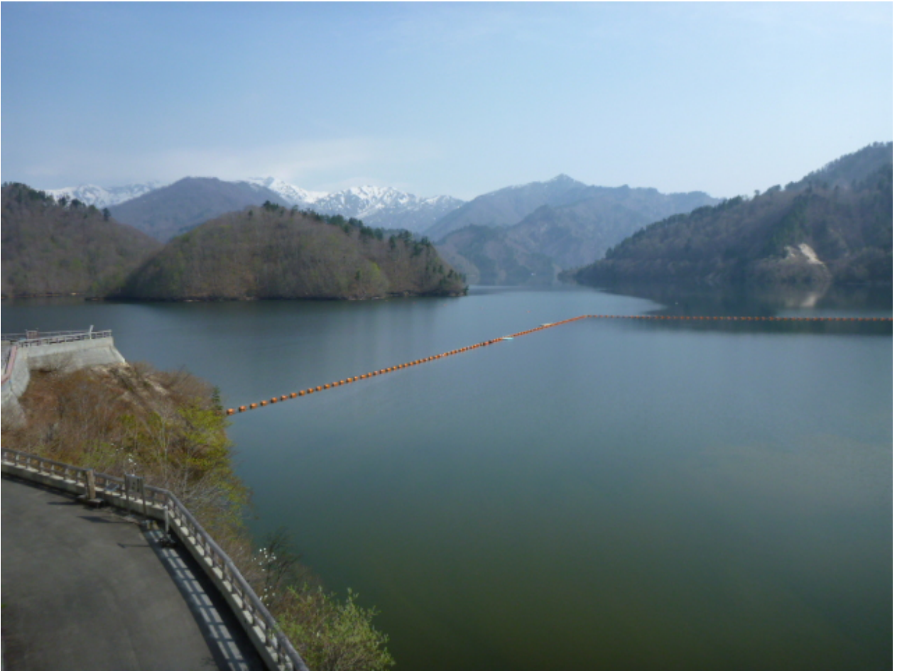
矢木沢ダム上流部（平成28年4月27日撮影）
