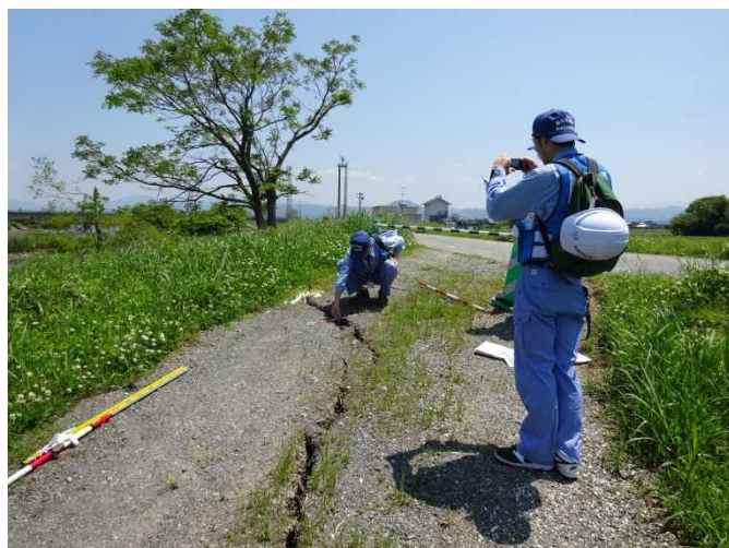
【舗装亀裂箇所の調査状況(熊本市)】
