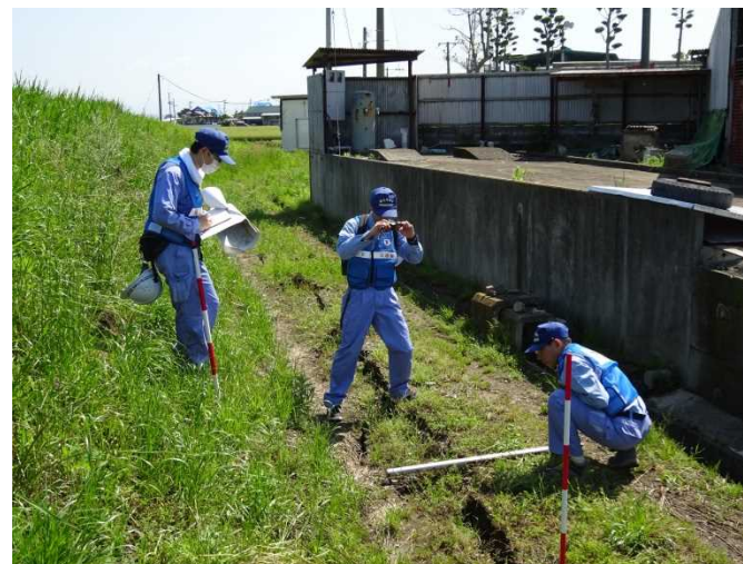
【堤防亀裂箇所の調査状況(熊本市)】
