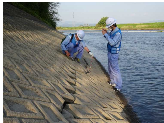
【護岸被災箇所の調査状況(熊本市)】
