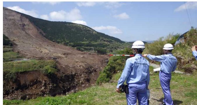
＜国道57号 阿蘇大橋周辺の現地調査を実施＞
