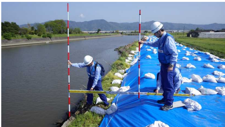
<15時頃 応急仮復旧箇所の調査>
