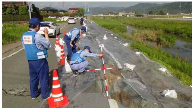
＜秋津川(あきつがわ)右岸堤防状況調査を実施＞
