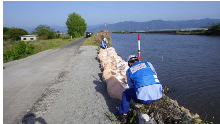
<16時頃 応急仮復旧箇所の調査>
