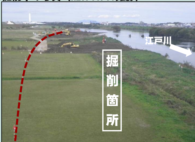
掘削中の写真 (H27. 11. 11撮影)
