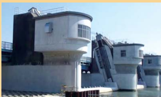
老朽化対策・耐震補強完了後
