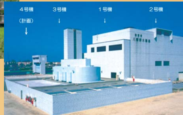
八潮排水機場
