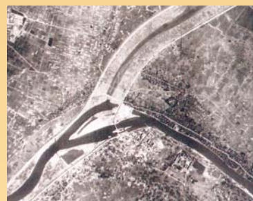
工事着手前の状況
