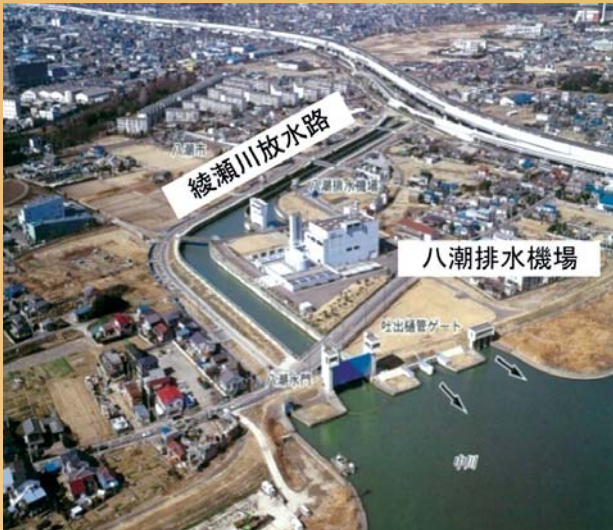
中川から見た綾瀬川放水路と八潮排水機場
