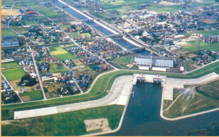
江戸川側から見た三郷放水路と三郷排水機場
