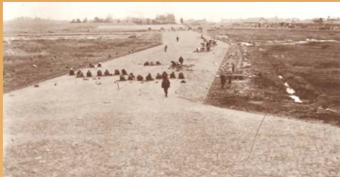
放水路床固工事
