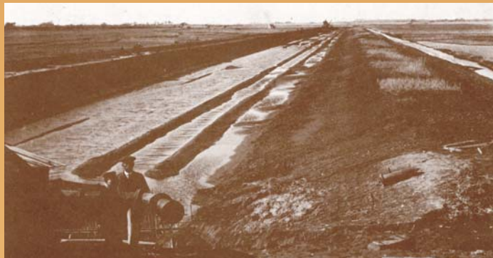
放水路の開削状況
