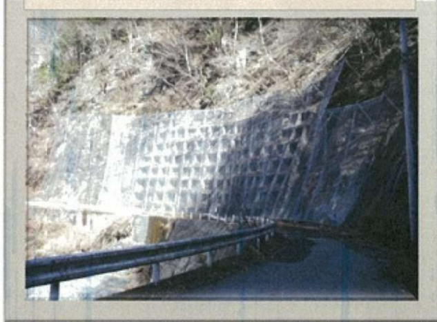
早川管内(雨畑) 落石防止の為に網を設置しています
