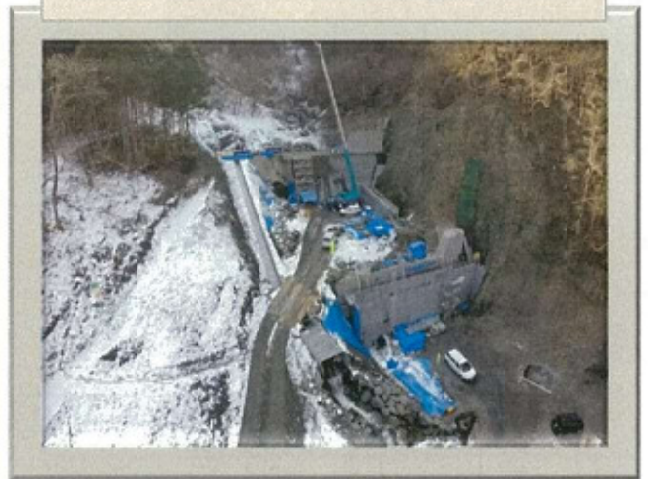
赤沢地先 春木川(池の沢) 砂防堰堤の補強を行っています
