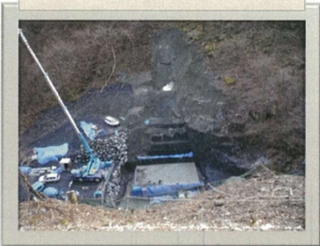
黒桂地先 黒桂河内川 砂防堰堤の整備を行っています
