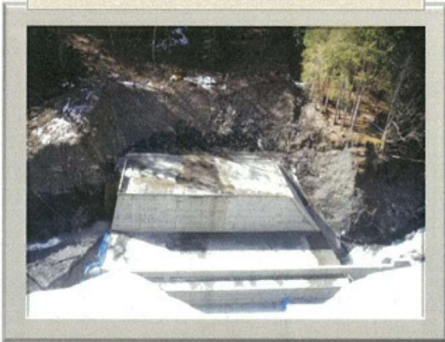
奈良田地先 内河内川 砂防堰堤の整備を行っています
