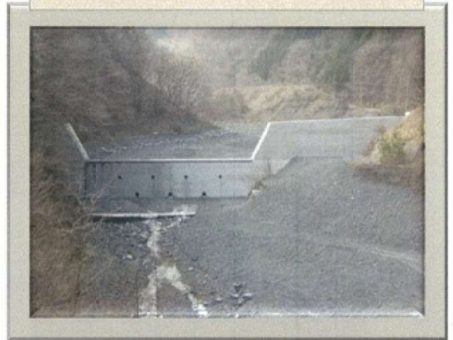
雨畑地先 稲又谷 砂防堰堤の補強を行いました
