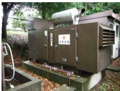
非常用発電機
