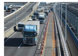
荒川河口橋の利用状況及びあて板設置状況 (H26.1.27 撮影)
