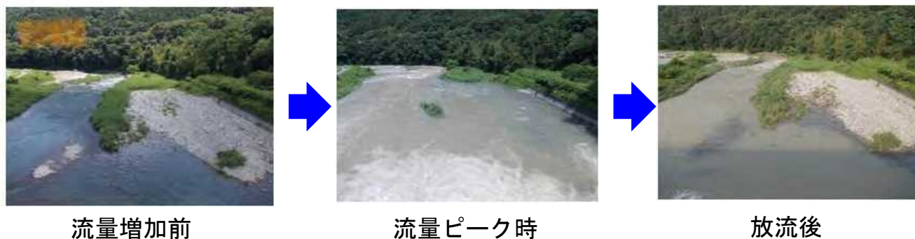
土砂掃流状況（平成24年7月）
