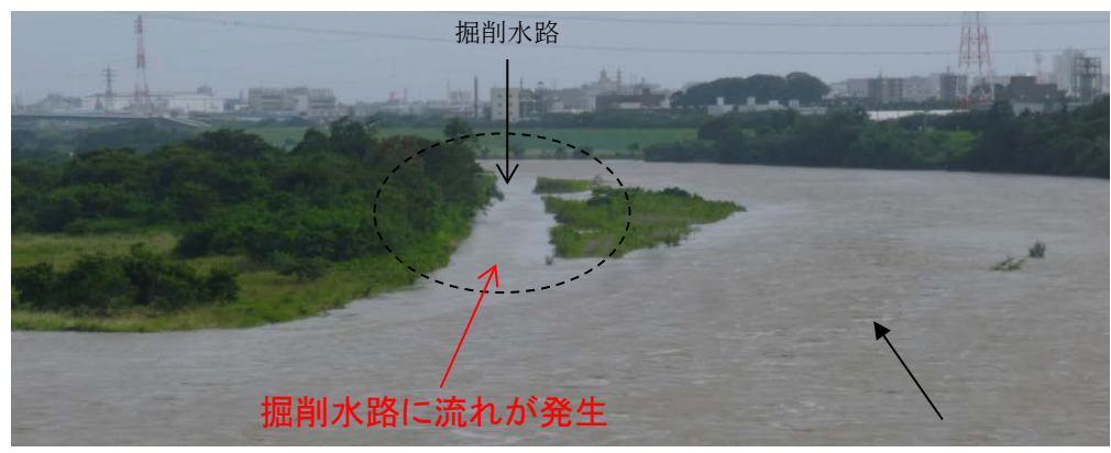
台風11号洪水中の状況（平成27年7月17日撮影）
