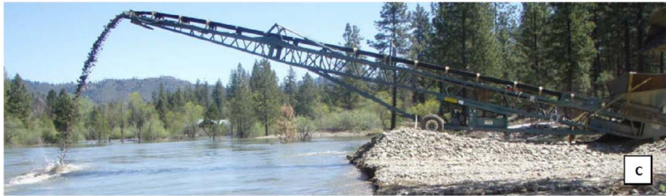
C:2011年の高水時に礫を直接的に給砂した(104.9マイル地点)。 ※1マイル=1.61 km
