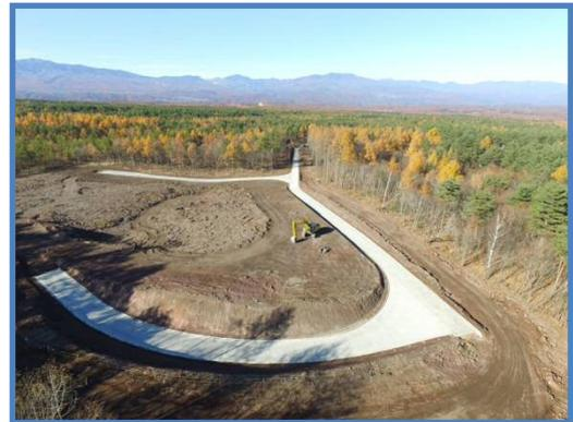
◆また、同嬭恋村鎌原地先「しゃくなげ園」付近の東側に位置する東泉沢においては、緊急減災対策施設としてコンクリートブロックを約300個使用した砂防堰堤を平成28年1月に完成しました。（写真右下）
