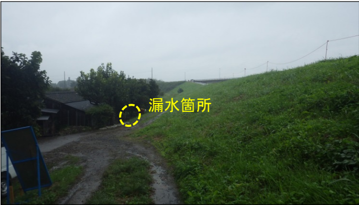
〔川裏～天端状況〕
