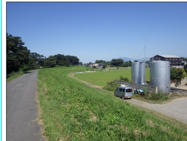
〔川裏～天端状況〕
