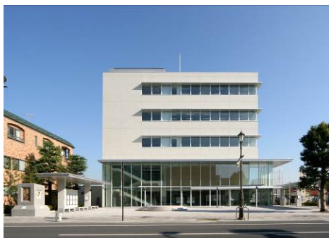
図3 開かれた合同庁舎（西側）
