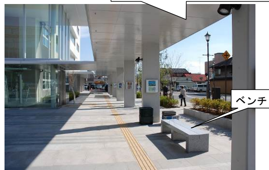
図4 親しみやすさに配慮した庁舎低層部
