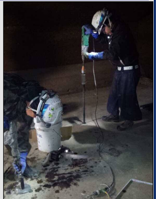
※補強鉄筋挿入状況（吸水路部）
