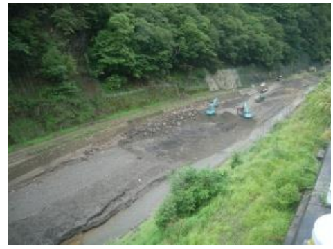
貯砂ダムの堆砂除去作業
