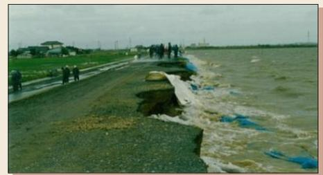
▲平成3年10月洪水の高波浪による侵食被害状況
