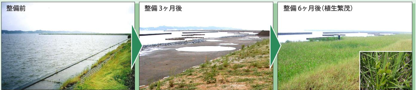
▲養浜による湖岸植生帯の再生 (石岡市 石川)
