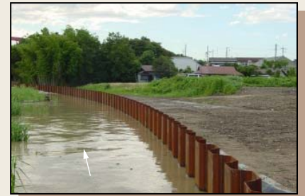
▲断面が不足している堤防
