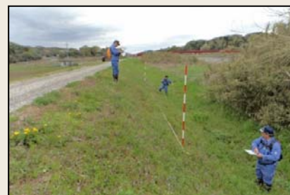
▲堤防点検状況
