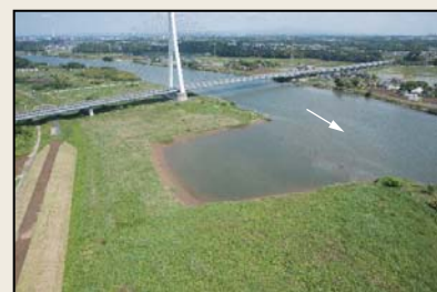
▲河道掘削試験施工地(那珂川下流部)
