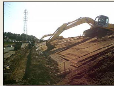
▲築堤工事の状況 (那珂川左岸三反田地区)
