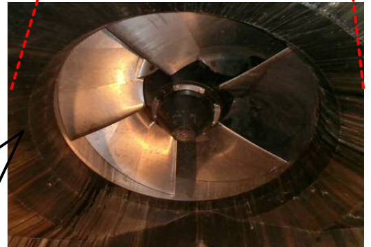
インペラ（羽根車）を下から見たところ 直径3.7m、重さ35t 毎秒50m 3 の水を排水（1台あたり）
