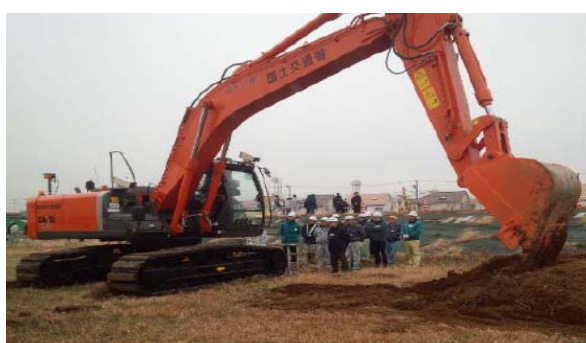
(一社)建設機械レンタル協会の協力による MGバックホウの機能・効果説明。 ※関東地整保有の分解型バックホウを使用
