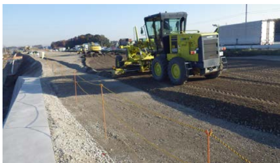
写真－１ 路盤敷き均し【MCグレーダ】
