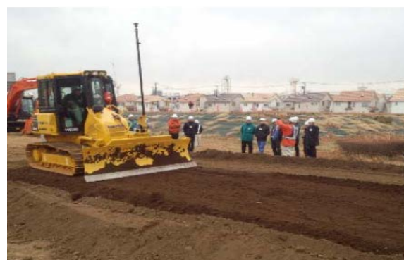
(一社)日本建設機械レンタル協会の協力による MCブルドーザの実操作体験。
