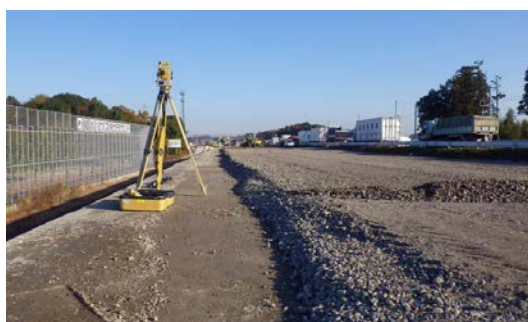
写真－２ 出来形計測【TS】
