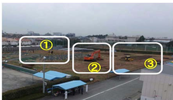
講習会場全景 ① TS出来形エリア ② MGバックホウ ③ MCブルドーザ
