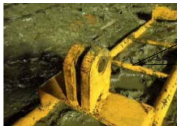
外れたボルト
